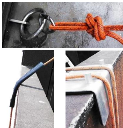
ビルクリーニング業務でのロープ高所作業の例
